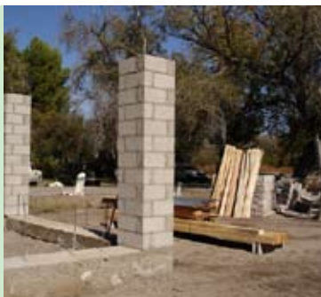
• muro de pacas con estructuras de soporte
